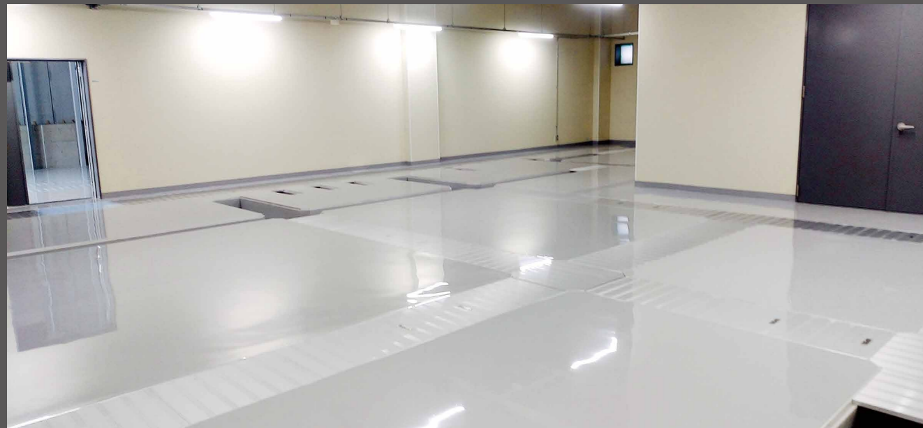
新幹線配電盤室 アルミ製スリット付中空パネル JP-WAVC-1
