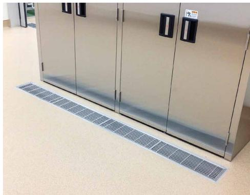
作業室の出入口に設置することで水を切ることができ、汚染された排水などが非汚染室や売り場、冷蔵庫内へ流入することを防止します。
