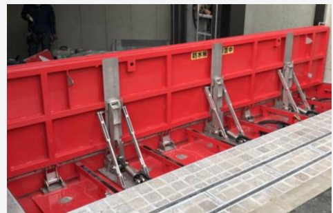
防水板 起伏時
