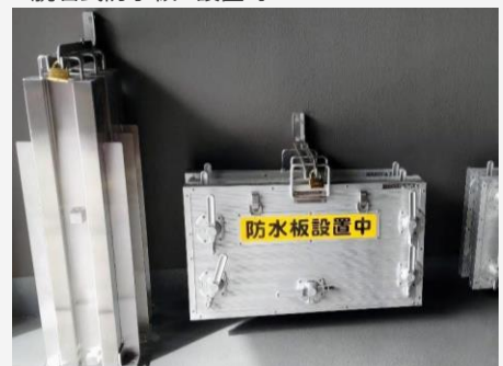
防水板のパネルが普段どこにあるかというと、専用フック等で収納されています。
