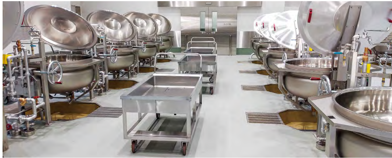
回転釜部 金場樹、阻集篦、見切り
