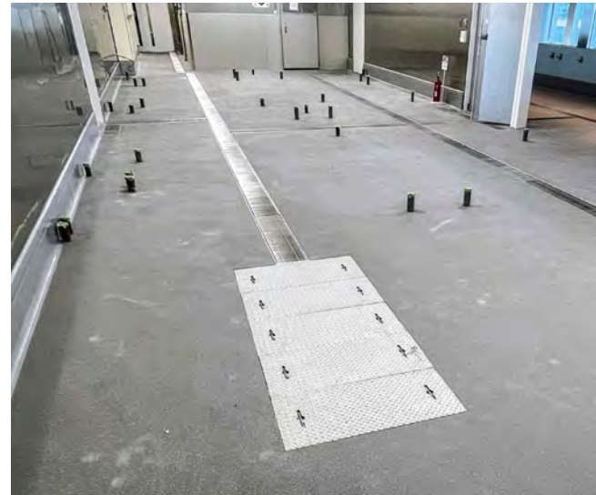
グリーストラップ廻り ステンレス竊板、ピット枠、グレーチング
