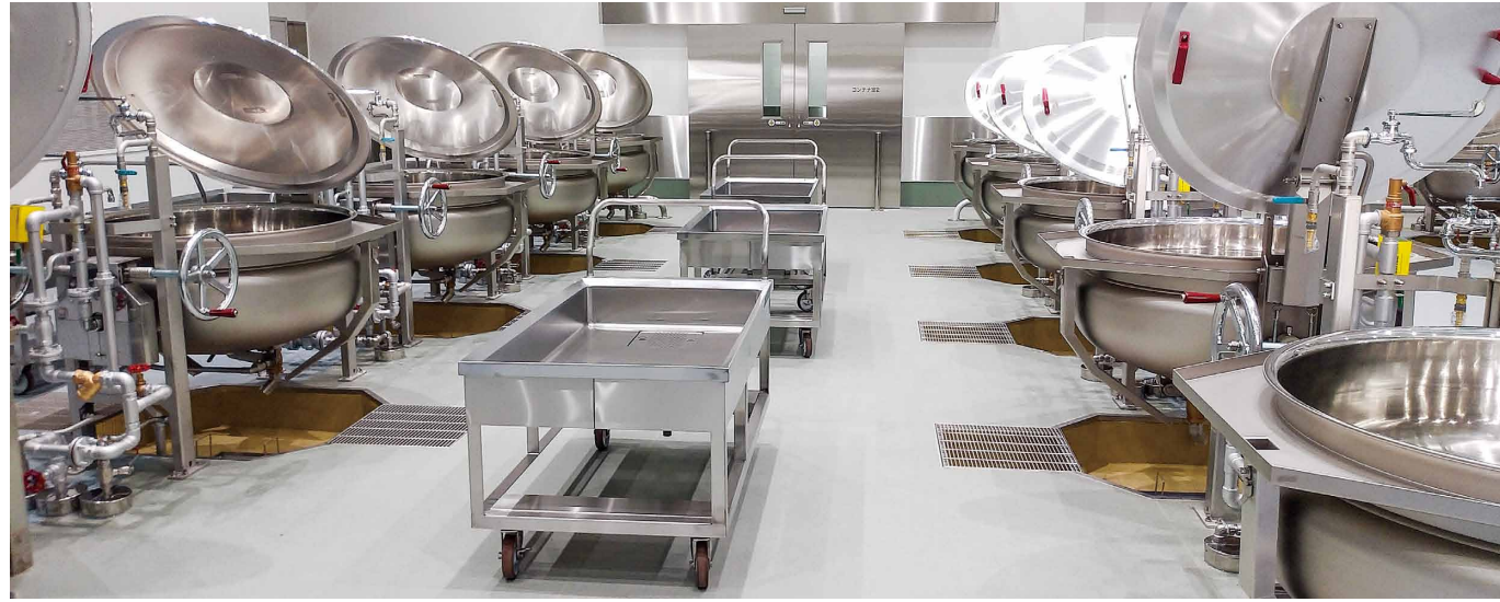
回転釜部 釜場樹、阻集篦、見切り
