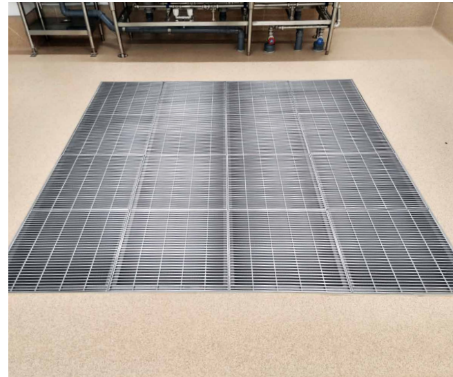
カート洗浄室 ピット枠、グレーチング
