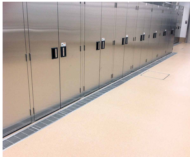
消毒保管機廻り グレーチング、ピット枠
