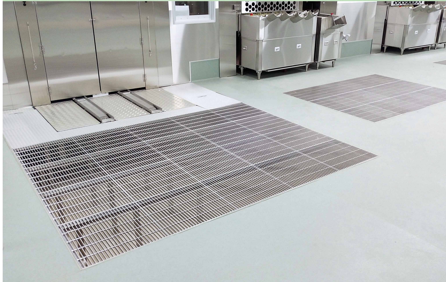
学校給食施設の排水用として ステンレス製グレーチング JP-APR
