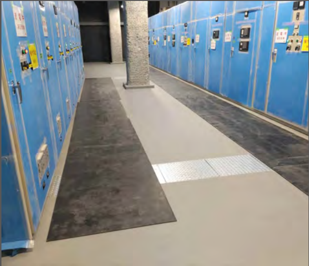
発電機室 縞鋼板
